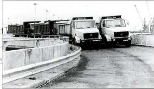
figure n° 1- Chargement de la travée centrale P5-P6
